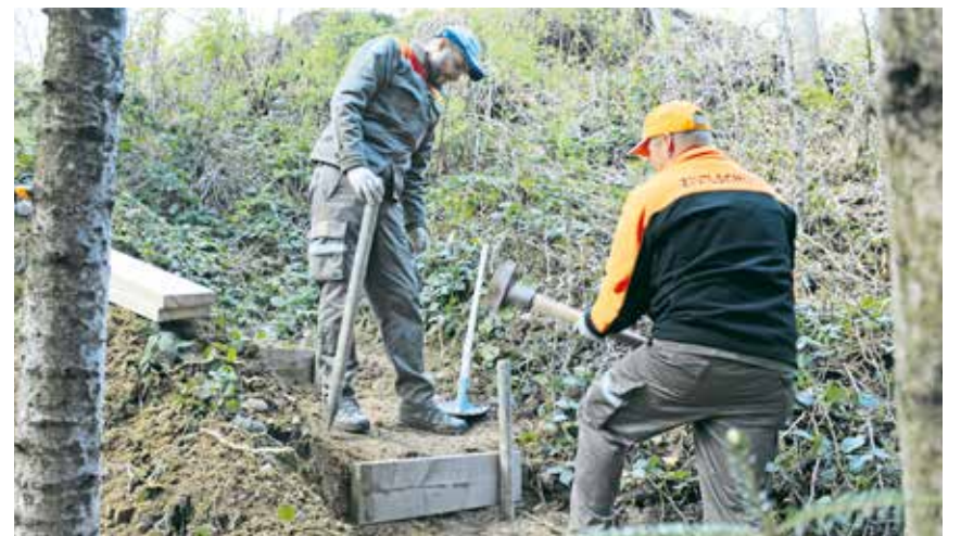
Zivilschutzleistende beim Einbau von Treppen im Steilhang des Fussweges Fanboden-Girislehnwald. Foto zvg
